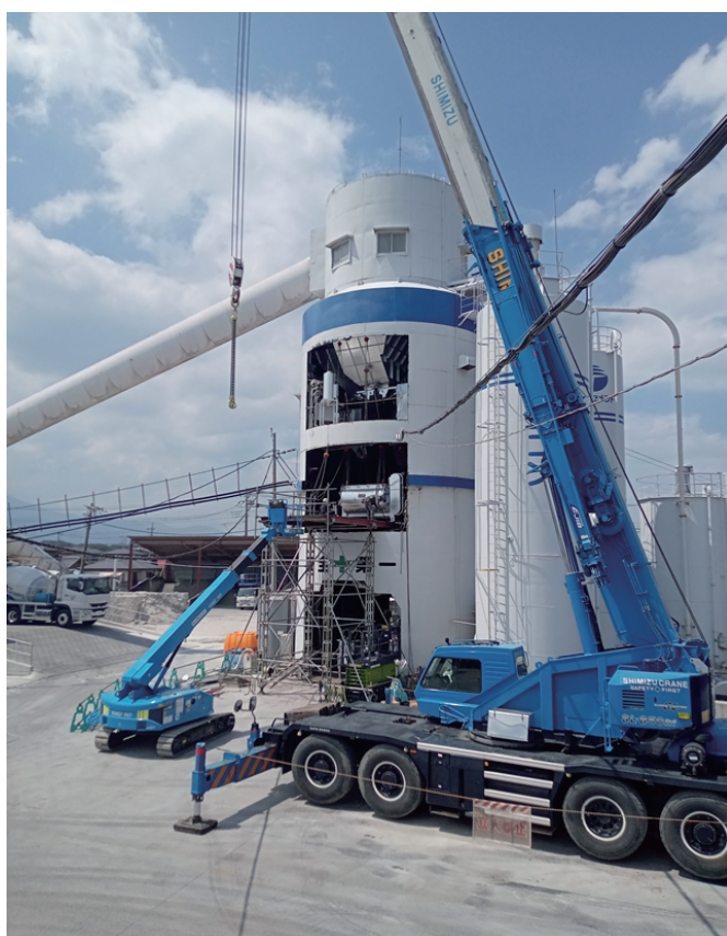
工事作業中の風景
